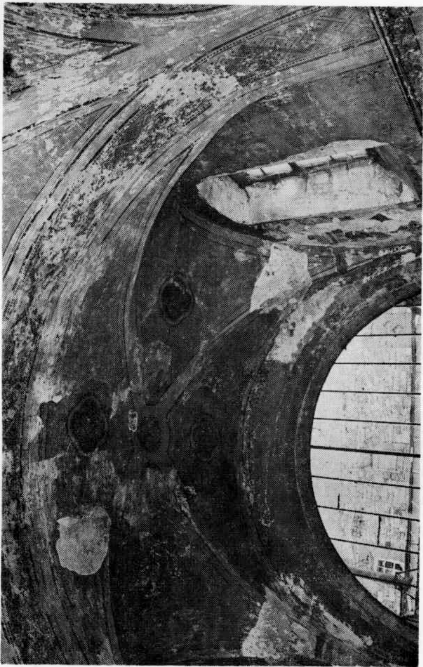
Fig. 2. — Le plafond de l'église des Capucins (XVII e ), aujourd'hui garage.
