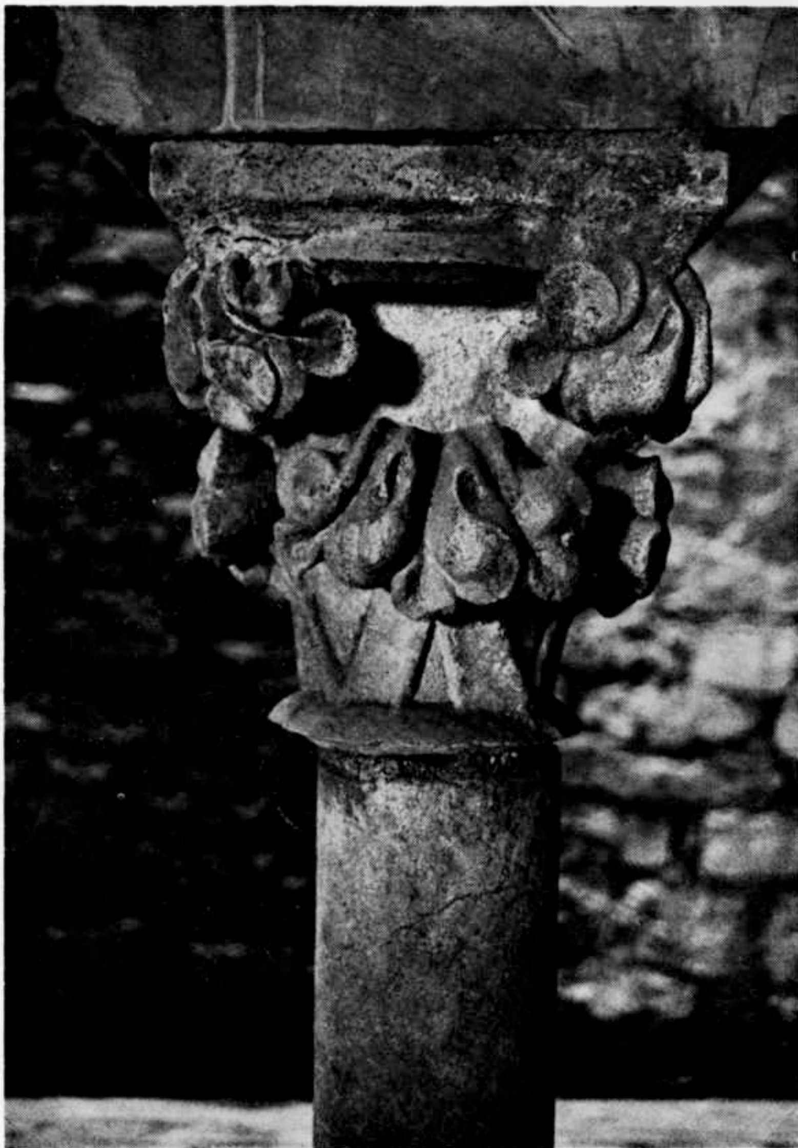
Chapiteau récemment découvert (fenêtre géminée premier étage).
