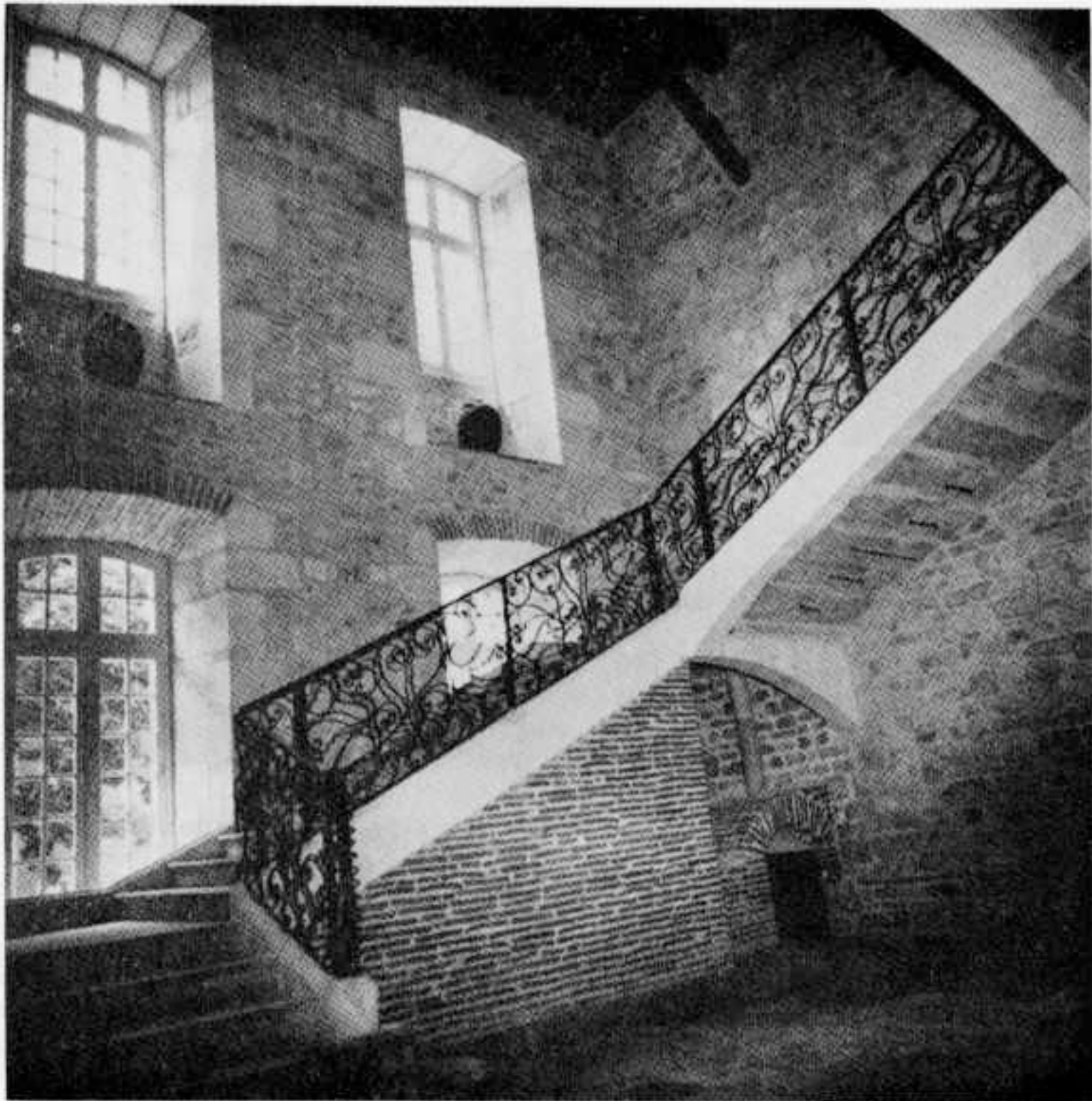
Illust. 8. – Le grand escalier et sa rampe d'origine.
