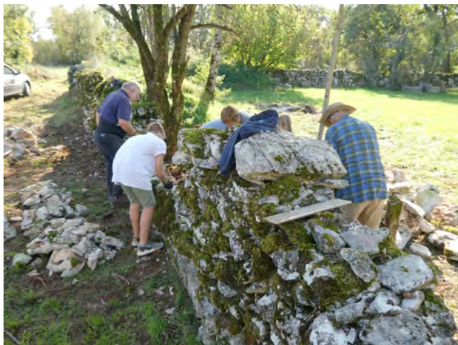
Chantier « muret » à Tabarly
