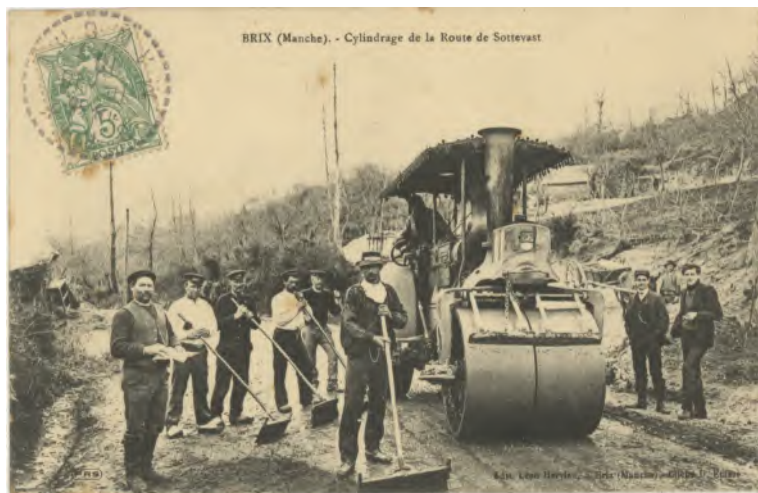
Dans le département de la Manche, cylindrage avec un rouleau à vapeur
