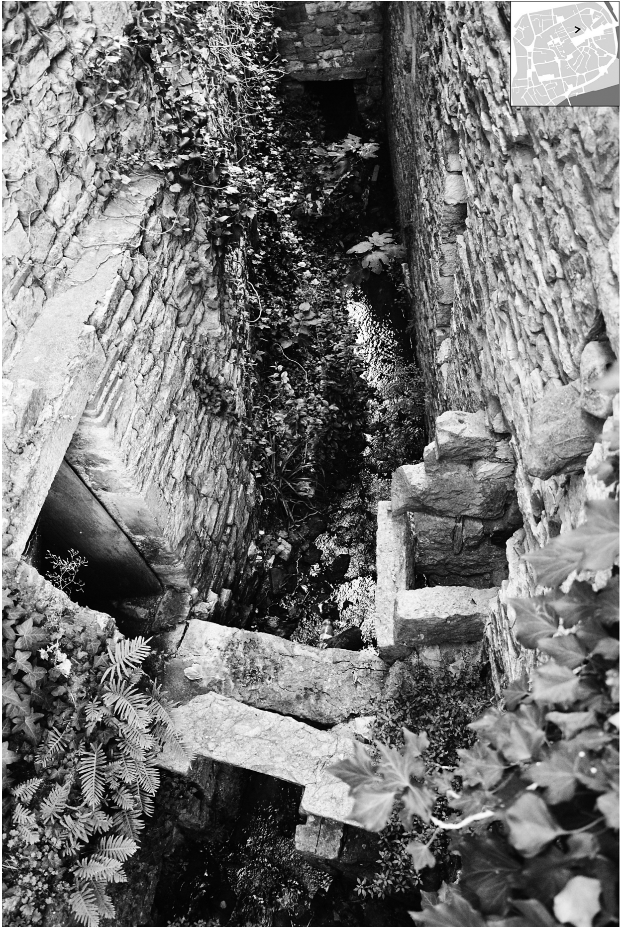
Fig. 9 : Canal transversal à ciel ouvert dans le quartier du Bessarel (C. Rivals).
