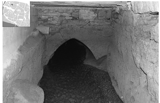
Fig. 7 : Canal de la dérivation inférieure observé à travers le regard de la rue du Moulin du Bessarel (C. Rivals).
