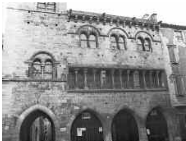
Fig. 4 : La façade est de l'ancien hôtel de ville.
