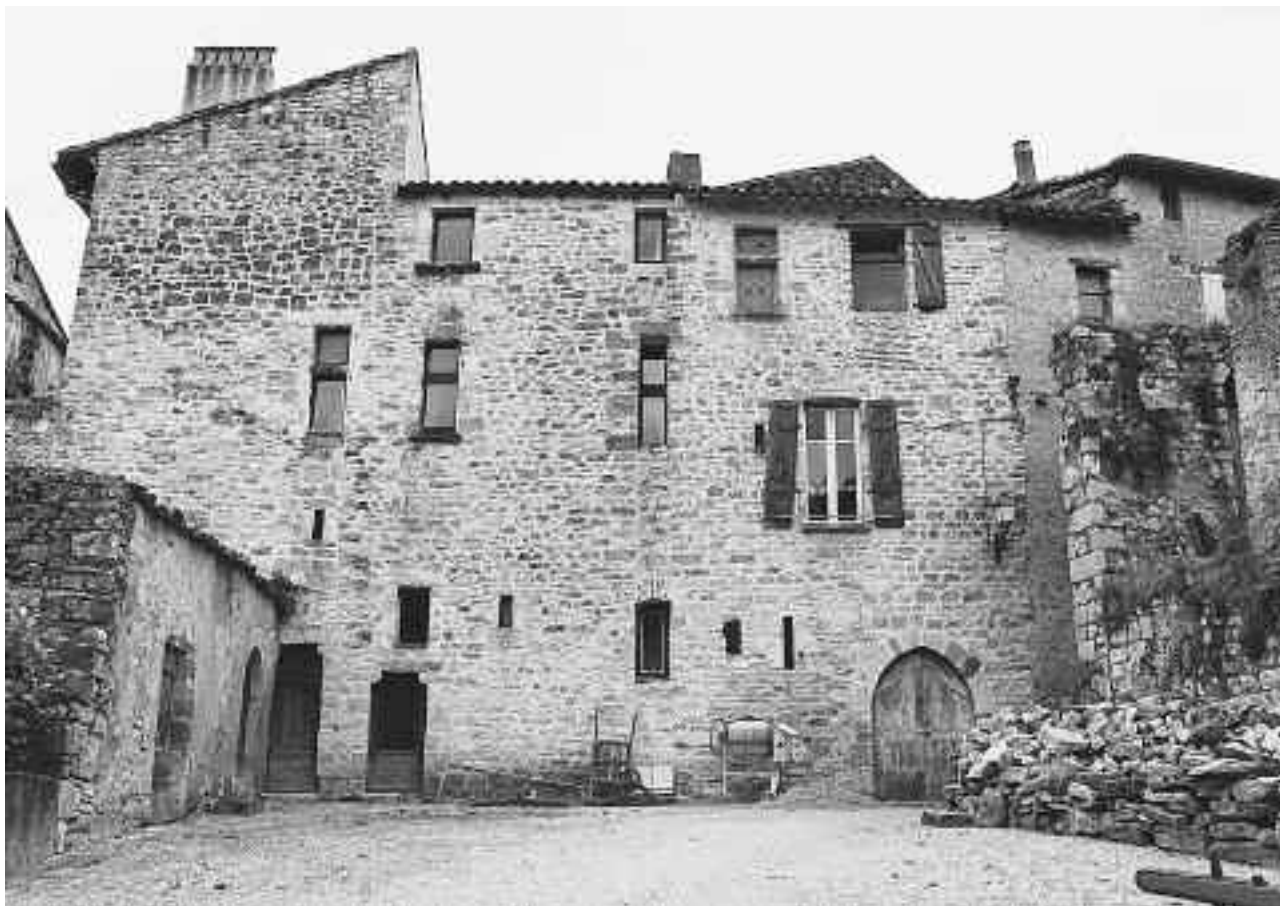
Fig. 32 : La venelle P4 (façade ouest du lot B).
