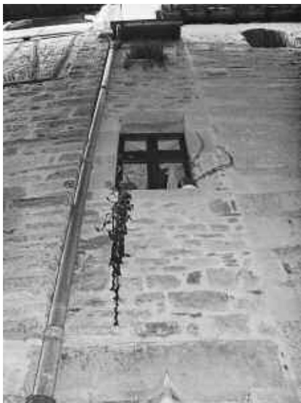
Fig. 19 : La ruelle P3 (vue depuis la rue Guilhem Peyre).
