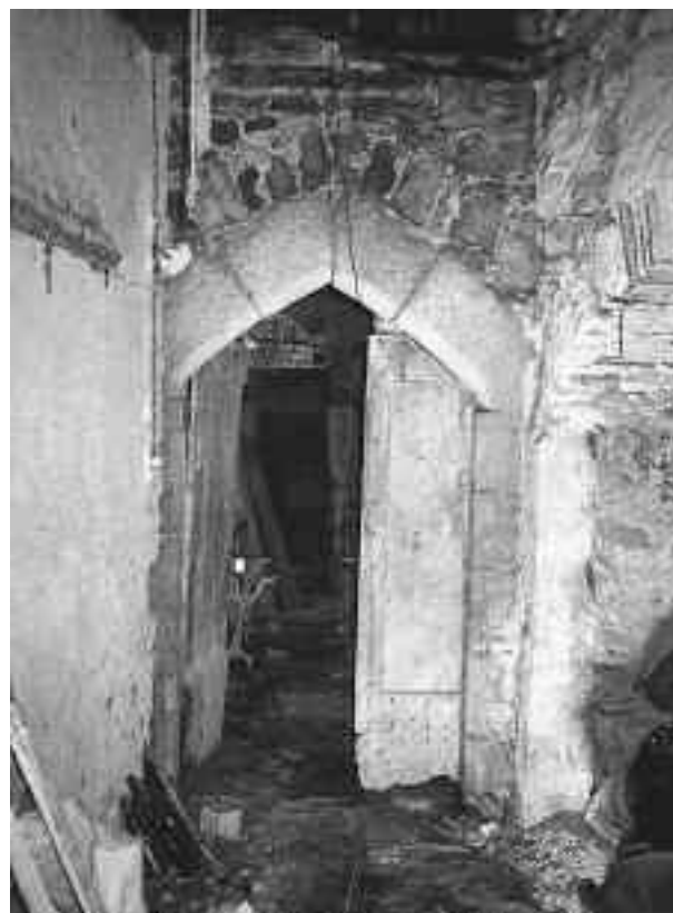
Fig. 15 : L'ouverture de A6 vers A5 (vue depuis A6).
