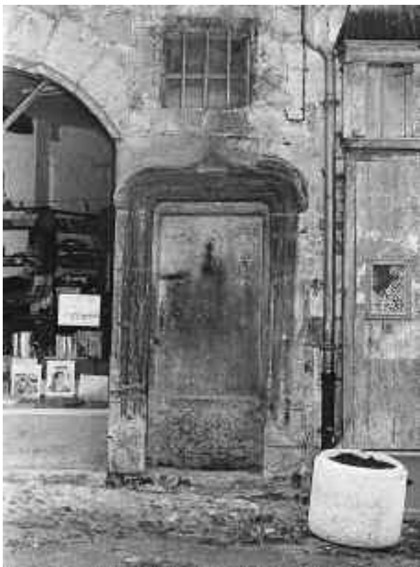
Fig. 28 : L'ouverture de A2 vers la rue de la Place (vue depuis la rue de la Place).
