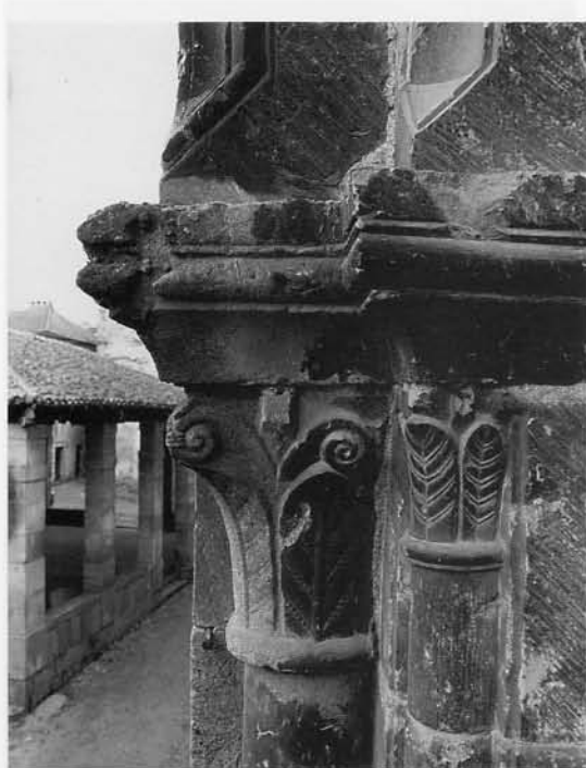
FIG. 44 - TOUR, CHAPITEAUX GAUCHES (SUD) DE LA FENETRE DU 1 er ETAGE (Cl. J.-F. Peiré / C. Soula, Inventaire Général).
