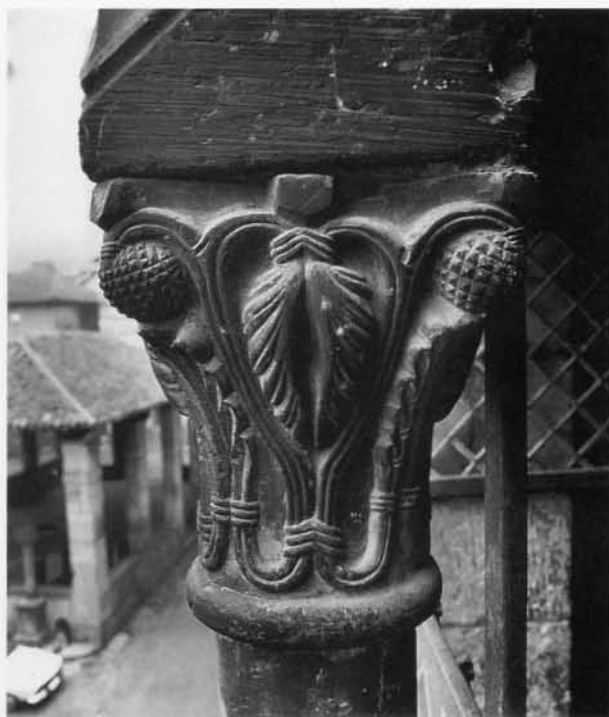
FIG. 41 - CORPS PRINCIPAL : CHAPITEAU DE LA FENETRE GAUCHE DU 2 e ETAGE (Cl. J.-F. Peiré / C. Soula, Inventaire Général).
