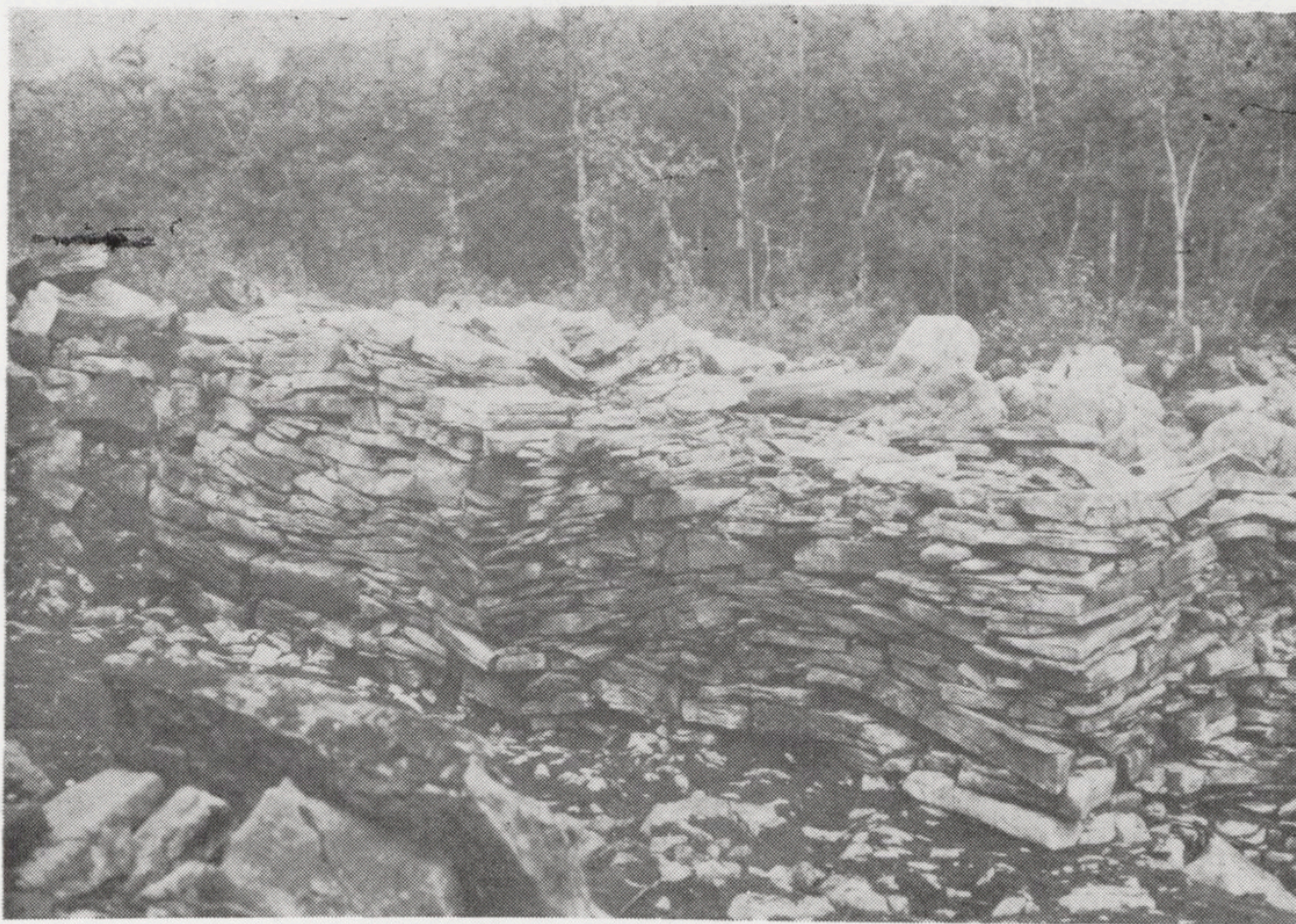
Fig. 9. — Dolmen du Rouzet (Larroque, Tarn). — Vue depuis le Sud-Est du parement du tumulus primitif (côté gauche et partie attenante de la façade).
