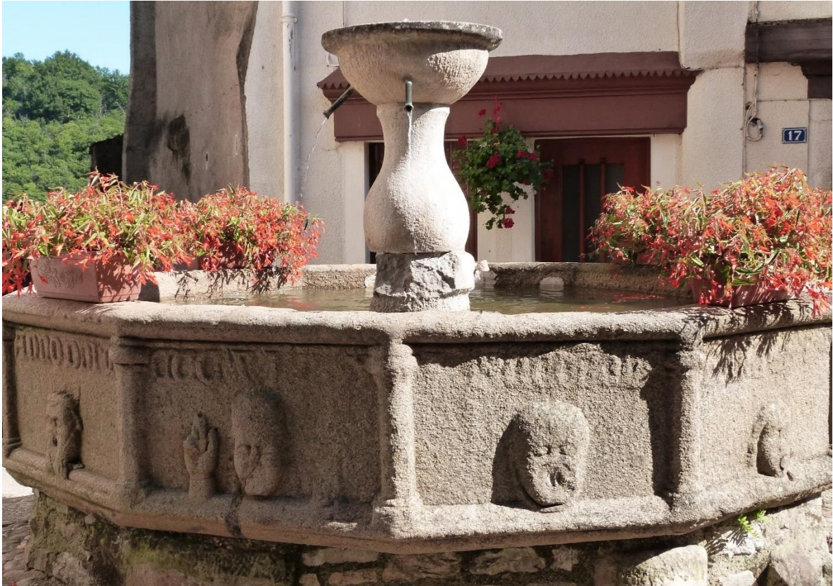
Figure 62 : Détail de la fontaine édifée à Najac par les consuls de 1344 (quatre premiers côtés du décor ; source : Wikimedia Commons)
