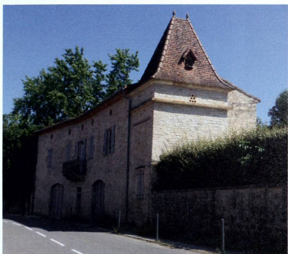
◀ Avenue Capin (direction Caylus) à Saint-Antonin.
