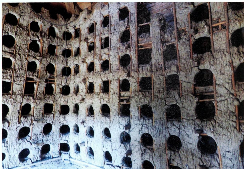
▲ Intérieur d'un pigeonnier
