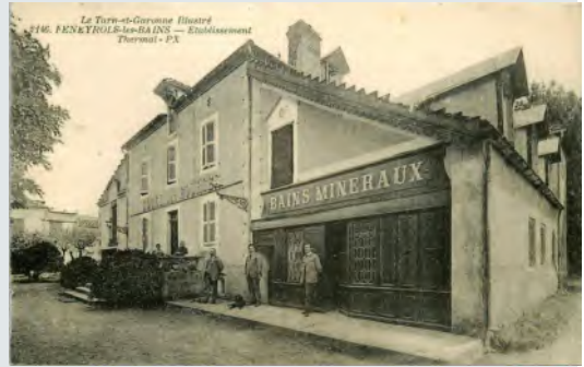
▲ La station thermale et l'hôtel des Sources ont deux consoles.
